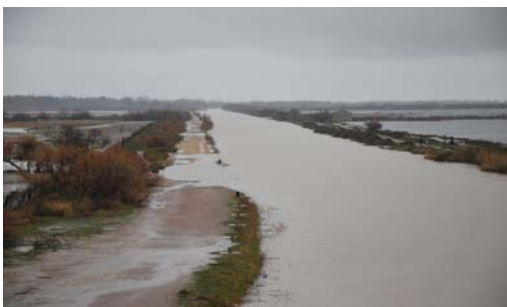
Fig. 9 Débordement du Canal du Rhône à Sète impactant tout le réseau pluvial N-E de La Grande Motte (4 février 2009) La berge sud doit être re-profilée dans le cadre d'un projet de modernisation de cette voie d'eau devant débuter en 2012
