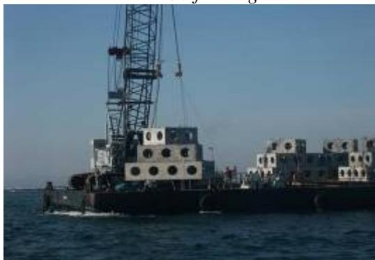
Fig 9 Immersion de récifs artificiels au large de Carnon
