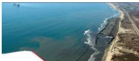
Fig5 : Barge déchargeant du sable au Petit Travers
